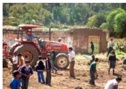
Huayocarri, juillet 2008 : le directeur de l'école supervise les travaux de réhabilitation du terrain
